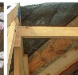
Pelējuma bojājumi, kurus radījis uzkrātais mitrums
